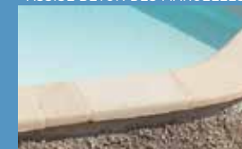
POSE DES MARGELLES
